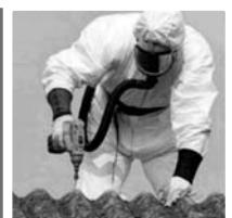
intervento di rimozione
