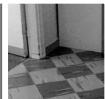
pavimento di vinil-amianto
