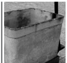
vasca di cemento-amianto
